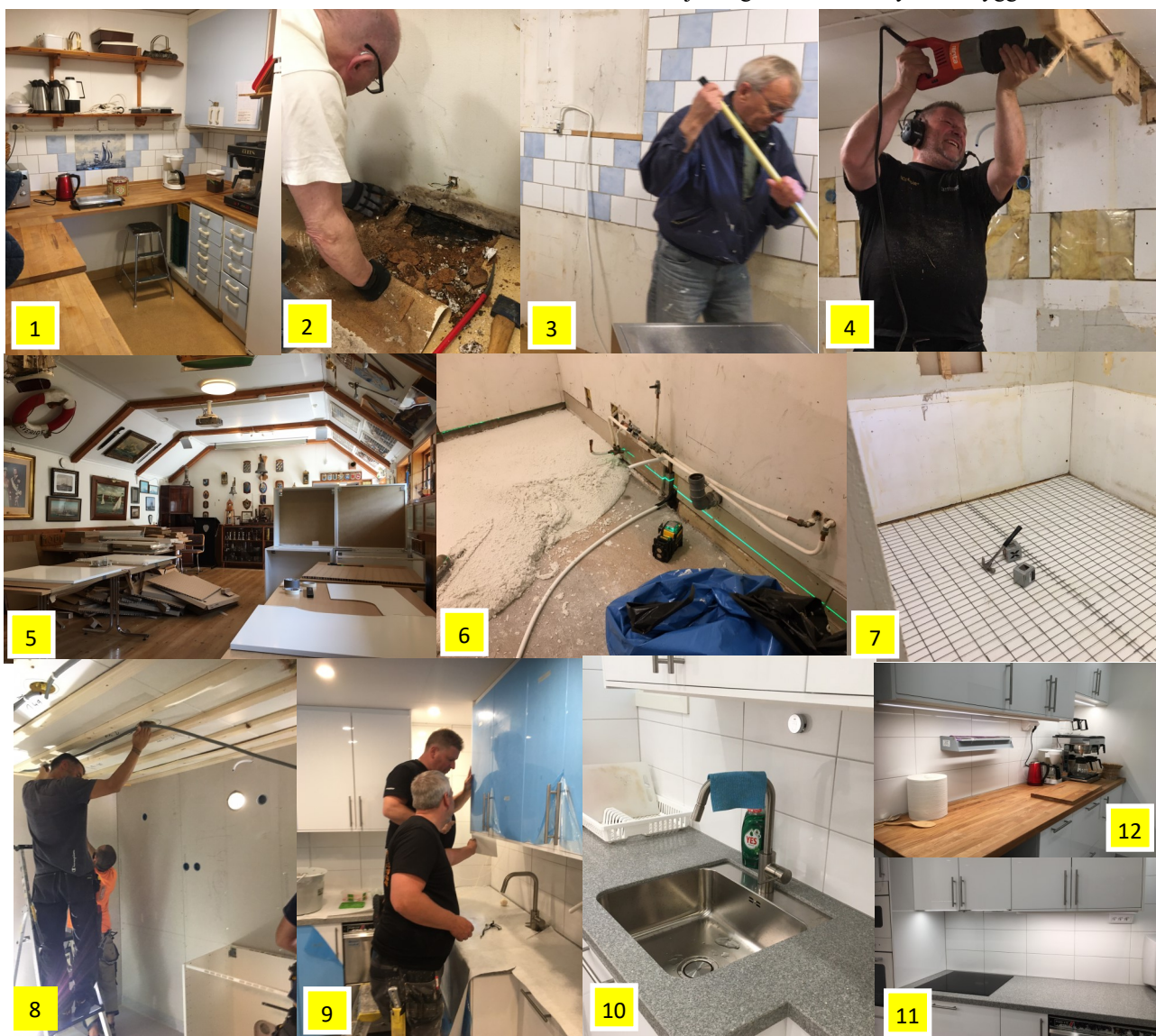
1 Gamla köket, 2 Gunnar konstaterar rötskador, 3 Utrivningen pågår Boris snyggat till, 4 Magnus på Eurobygg tar ned en balk, 5 Storstugan blev monteringsplats i juli, 6 Eurobygg gjuter golvet i lätt betong, 7 På betongen läggs armering för flytspacklet, 8 KSS Bygg bygger nytt tak med spottar, 9 Eurobygg (Magnus och Joakim) kaklar, 10-12 Nytt kök står klart 2021-08-19.
