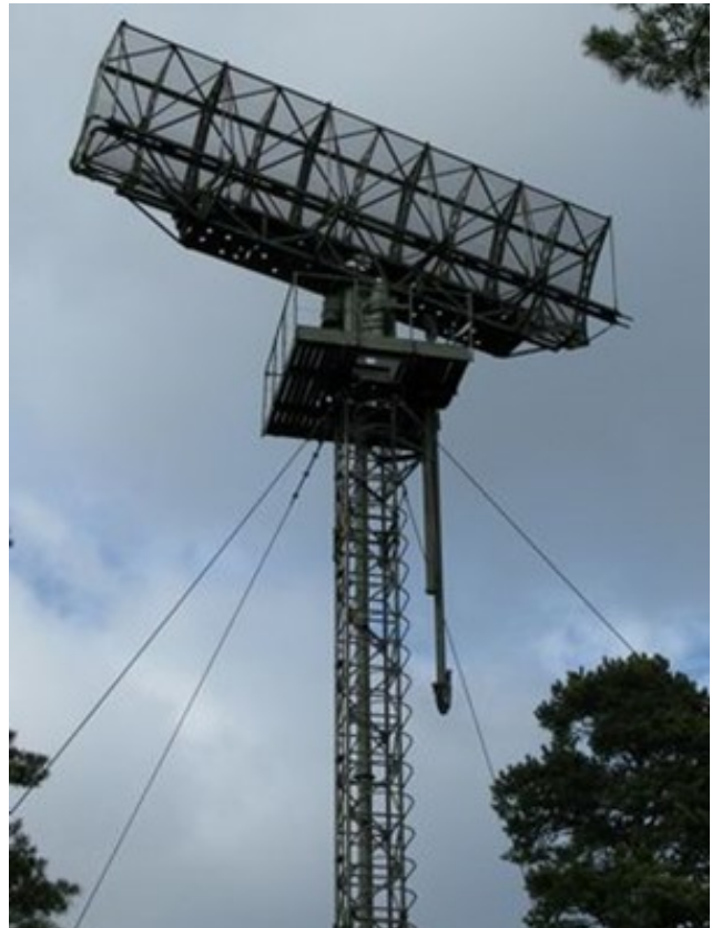
Antenn till kustspaningsradar monterad på en fackverksmast.
