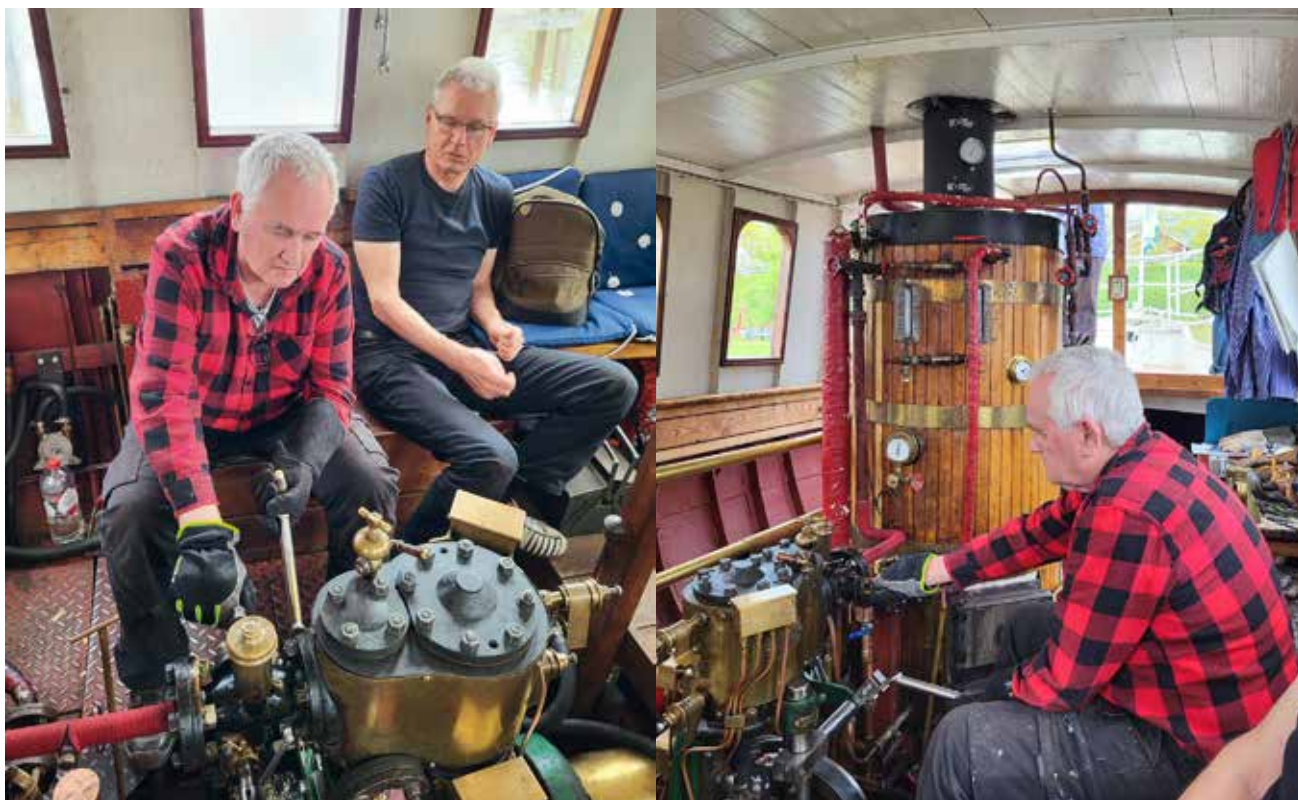
Ångmaskinen som utvecklar 8 hästkrafter står mitt i passagerarutrymmet.
