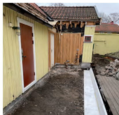
Första veckans ombyggnadsarbeten för ny bottenplatta för den ca 20 m2 nya toalettdelen och nya huvudentrén mot gården. Gamla toalettdelen riven. Foto: Arkitekt Hans Utstrand, FM Göteborg.
