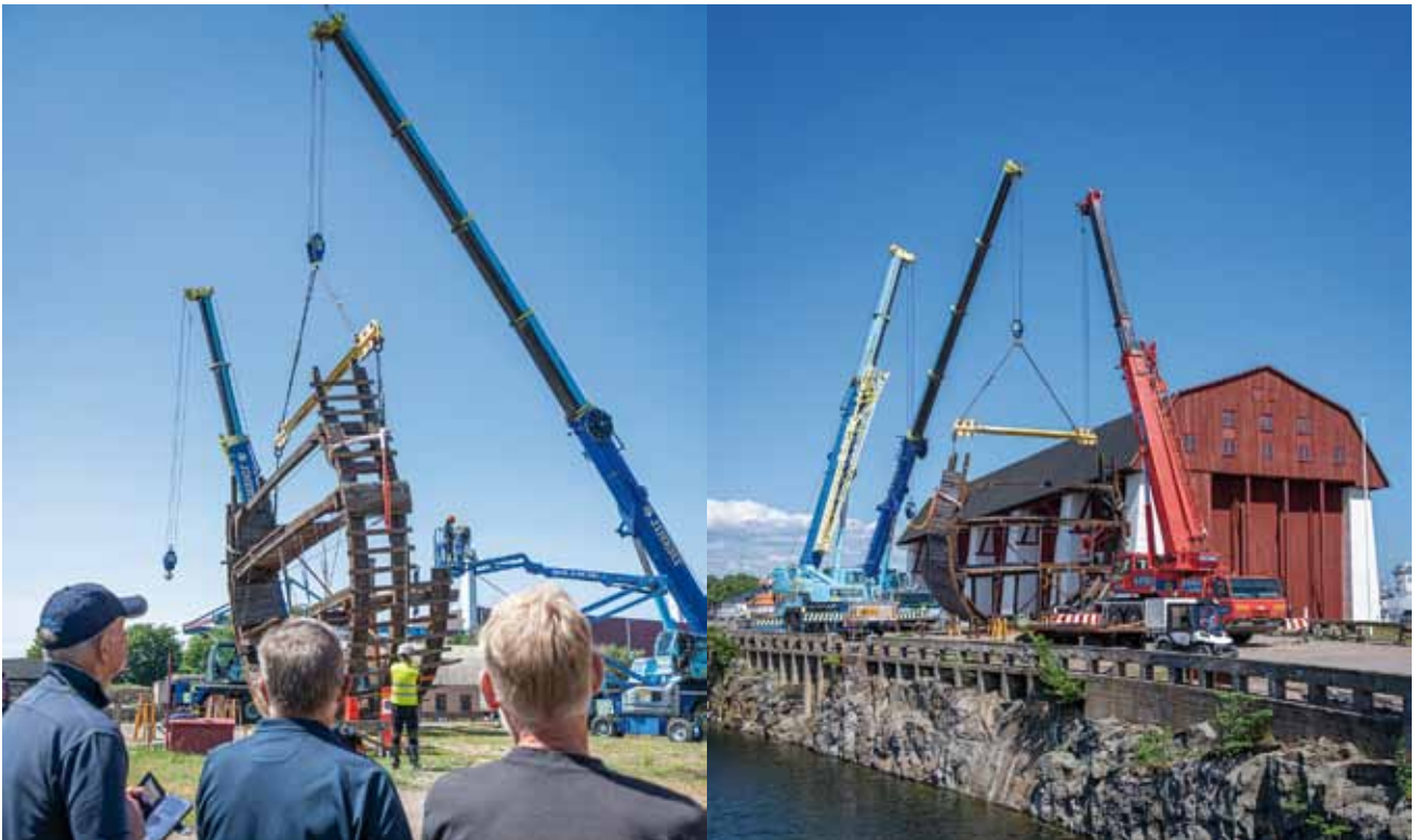
Våren 2023 kunde äntligen spantet sättas på plats på Lindholmen och spantsektionen har placerats exakt på samma plats, som linjeskeppen byggdes för 250 år sedan. Foto: Camilla Granström/Försvarmakten.
