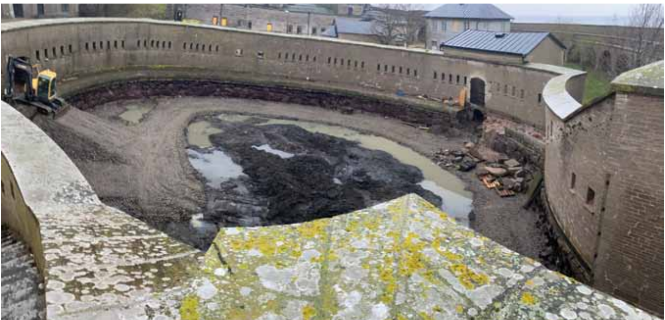
Genomgripande arbeten har genomförts och pågår. Sluphamnen har torrlagts för att kunna förstärkas.
