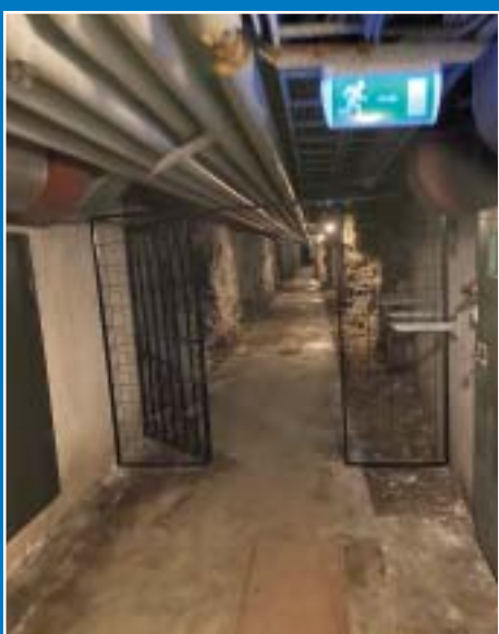
Förbindelsegång i anläggningen
