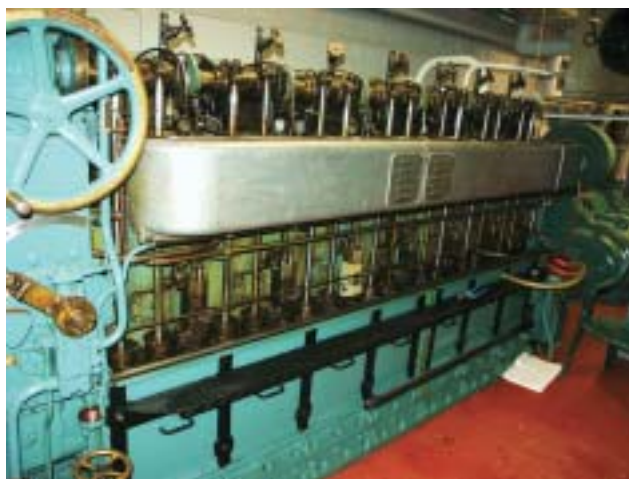
Reservkraft från diesel som tidigare funnits i ubåten Nordkaparen
