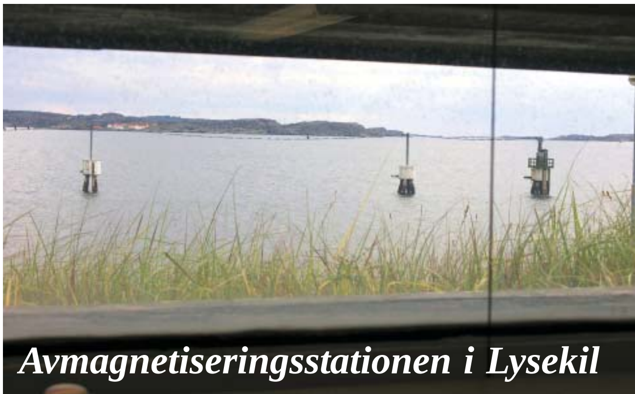
Utsikt från bunkern mot dykdalber med luftslingor
