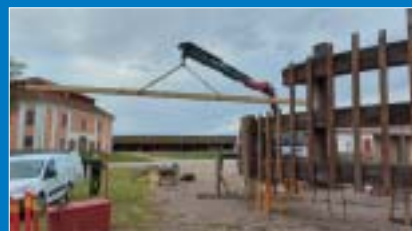
Den tredje och sista däcksbalken lyfts på plats
