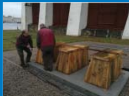
Kölblocken av betong kläs med ek för att få ett tidstypiskt utseende
