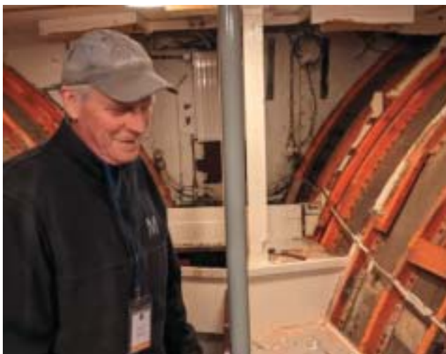
Förliga skansen under och efter renoveringen
