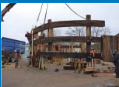
För att underlätta arbetet med spannten, placerades de liggande
