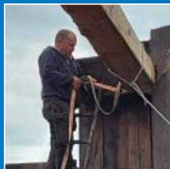
Per-Anders Daag ser till att däcksbalk kommer på rätt plats
