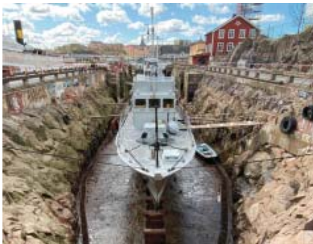
M 20 indockad i västra dockan på Beckholmen
