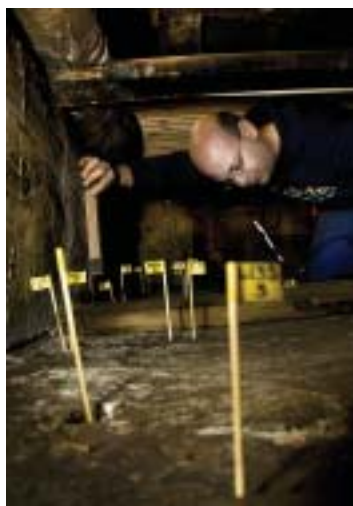
Med hjälp av trästickor mäts Vasas invändiga stomme och bärande konstruktion nu för första gången upp. Foto: Johan Bergling
