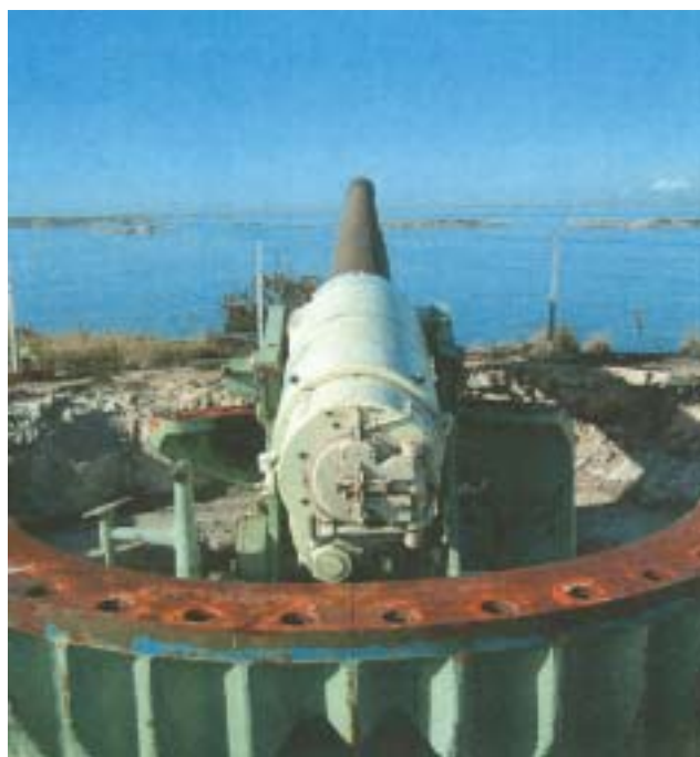
Arbete med återmontering av 15,2 cm pjäs från batteri Styrso. Foto: Statens fastighetsverk
