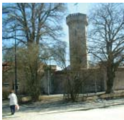
Vattenborgen före ombyggnaden
