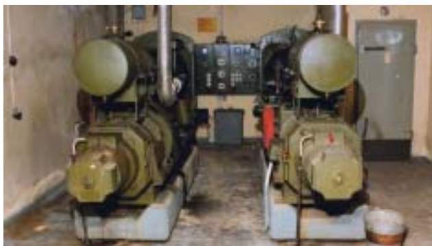
Två kraftaggregat för strömförsörjning
