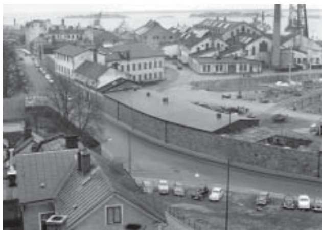
Stora verkstadsbyggnaden och varvsmuren. Foto Lennart Bergquist
