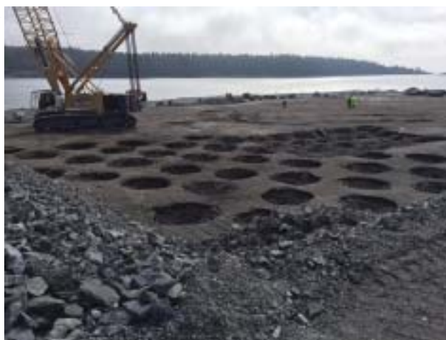
Markkomprimering på gång
