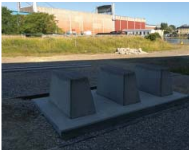
De tre kölblocken i betong som rekonstruktionen ska placeras på.
