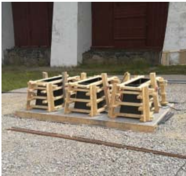
Formarna till de tre kölblocken under byggnation på den gamla stapelbädden vid Wasa skjul
