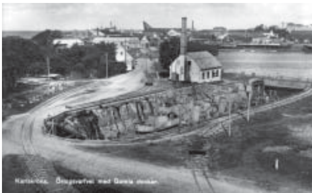
Spårsystemet vid Polhemsdockan. Spåren användes både för tågtrafik och för varvets kranar Bild Blekinge Museum
