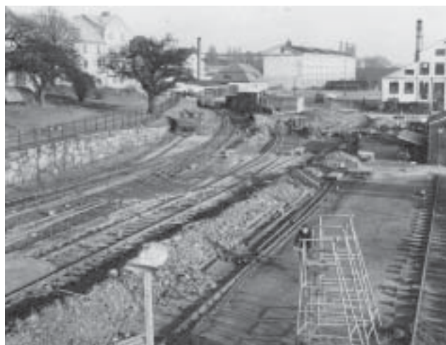
Omläggning av spåren i Örlogshamnen 1954. Foto Försvarmakten
