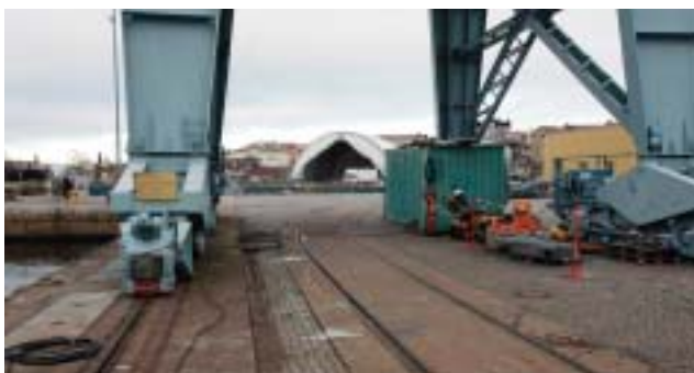
Det mesta av spåren i Örlogshamen och på varvet är idag bort och endast ett fåtal meter återstår Foto Ingmar Elofsson
