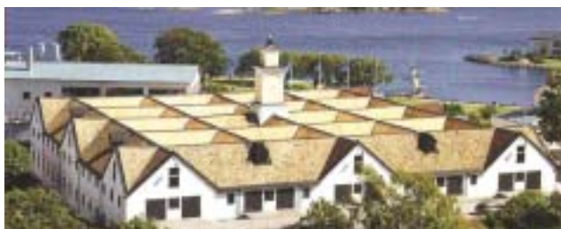
Takkonstruktionen på Slup- och barkasskjulet
