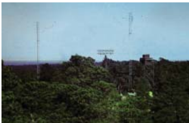
Antennmast på Gotska Sandön
