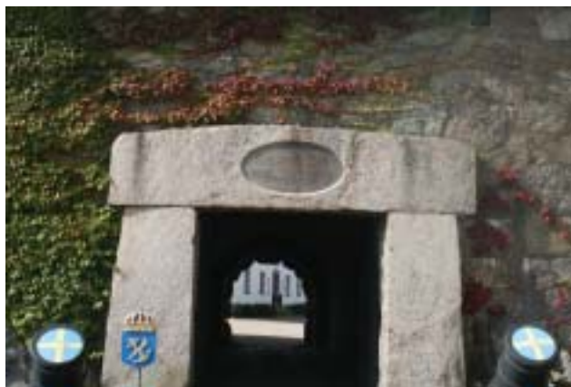
Kungsholms fort är idag slutet med IX linjer. Här syns Linje VII med ingång till fortets slutna del. Detta valv togs upp på 1870-talet. Den översta stenen i valvet, slutstenen väger 16 – 18 ton, högs på Tjurkö och transporterades till fortet. Foto Olle Melin
