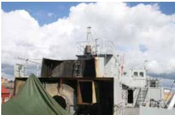
Rester av överbyggnaden efter huvudmotorlyft. Foto Olle Melin
