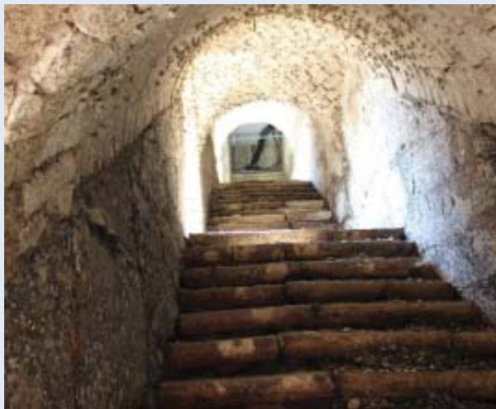
Nedgång till dockkulvert. Foto Christer Karlsson
