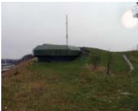
Bunker med lasermätare, tidigare lodbas
