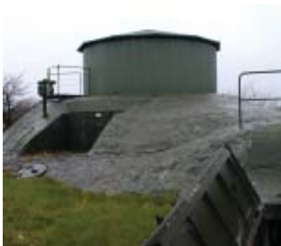
Nedgång till huvudanläggning. Bakom kupolen finns radarantennen
