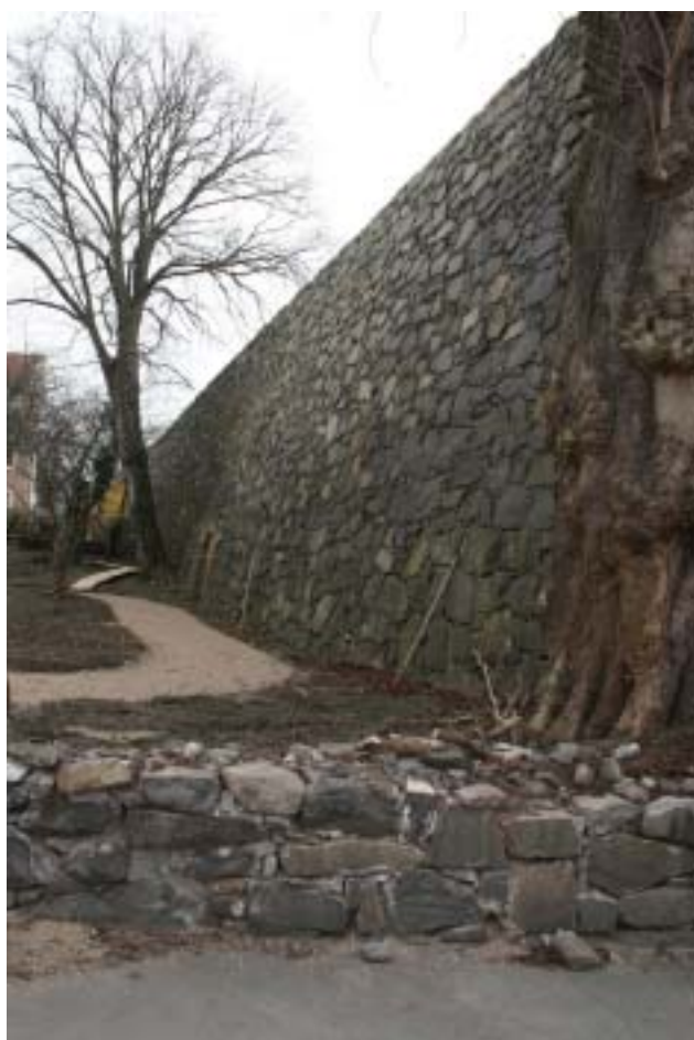
Sträckningsmuren vid Varvsgatan
