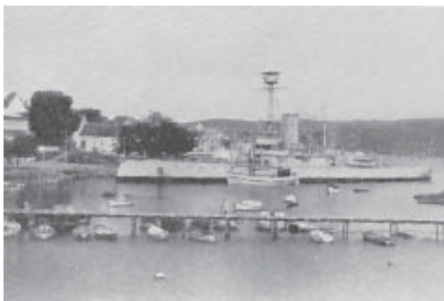
Logementsfartyget Niord i Marstrand. Bild Skeppsgossen
