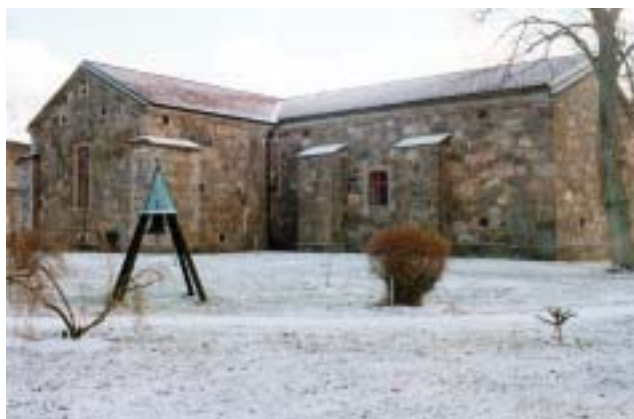
Stenkyrka i fortparken. Delen till höger är fortets äldsta bevarade byggnad från 1750
