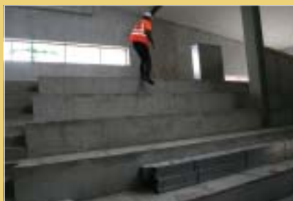
Blivande läktare åt söder
