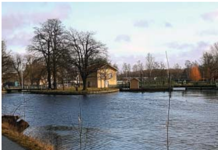
Här fördelar Svartån sin resurs mellan slussen och det som var platsen för en kraftstation
