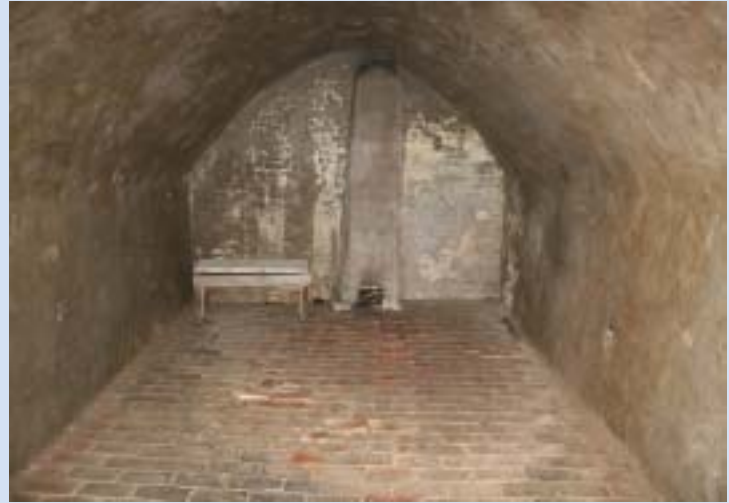
Karlshamns kastell. Krutkällare
