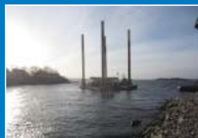
Pålkran på väg mot arbetsplatsen
