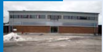
Den nya skollokalen för Sjöstridsskolans skeppstekniska sektion. Den teglade delen är det gamla kallförrådet och byggnaden har sedan byggts på med två våningsplan
