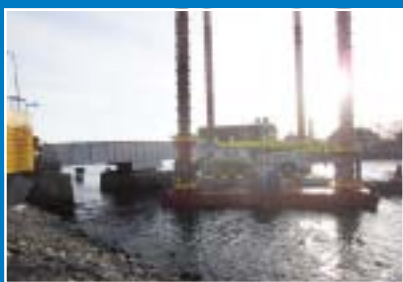
Pålkran på plats
