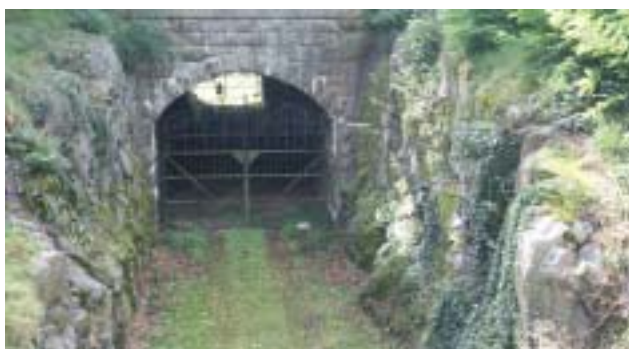
Järnvägstunneln under Stortorget i Karlskrona. Foto Olle Melin
