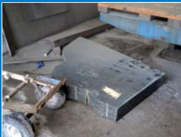
Stenen har måttsågats och är klar tillsättning.
