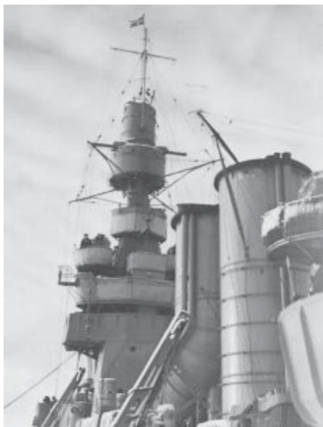
Bryggkomplexet på HMS Sverige . Högst upp stridsmarsen med centralsiktet och avståndsmätaren för svårt artilleriet. Under strålkastarbrygga och signalbrygga. Bakom aktra skorstenen ytterligare en strålkastarbrygga.
