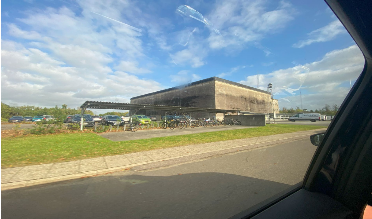
Flygledningscentralen på Karup ett minne (bunker) av tyskarna från andra världskriget
